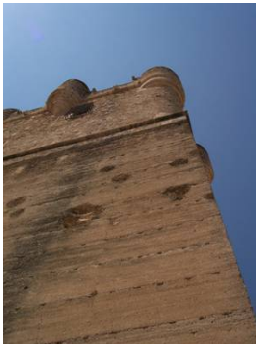
Torre del Castell de la Atalaya. (Villena) Mostra dels impactes de l'Artilleria Anglo-Portuguesa en 1707.
